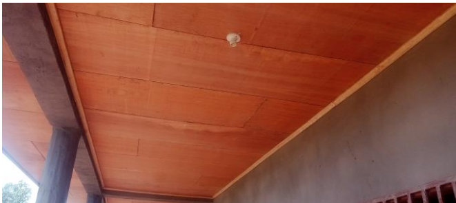
Photo 1 : Plafond achevé et travail de pose de cornière
