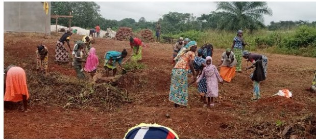
Photo 4: Travail d'investissement autour du bâtiment en construction (Suite)
