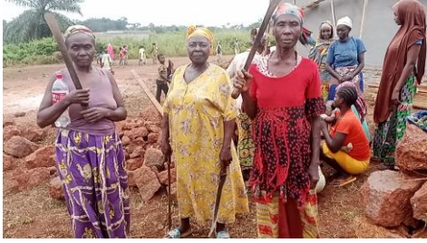
Photo 1 : Travail d'investissement autour du bâtiment en construction
