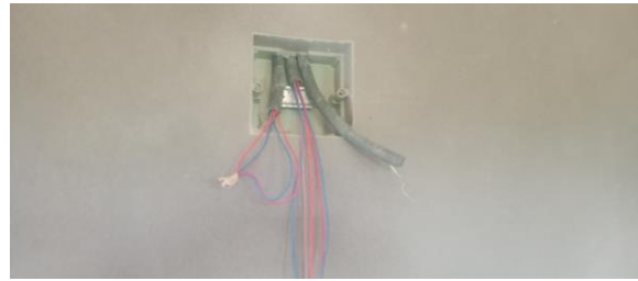
Photo 6 : Installation du courant dans tout le bâtiment
