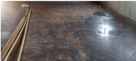
Photo 5 : Sol cimenté et les cornières posées au sol
